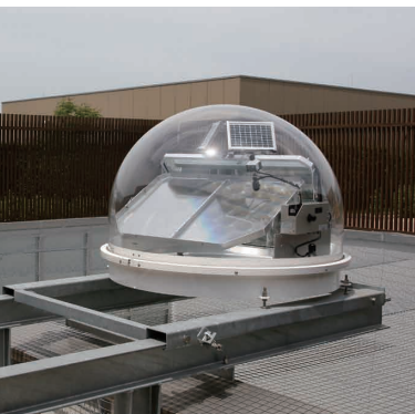
屋上には庭園が設けられ、太陽追尾式の集光装置を配置
